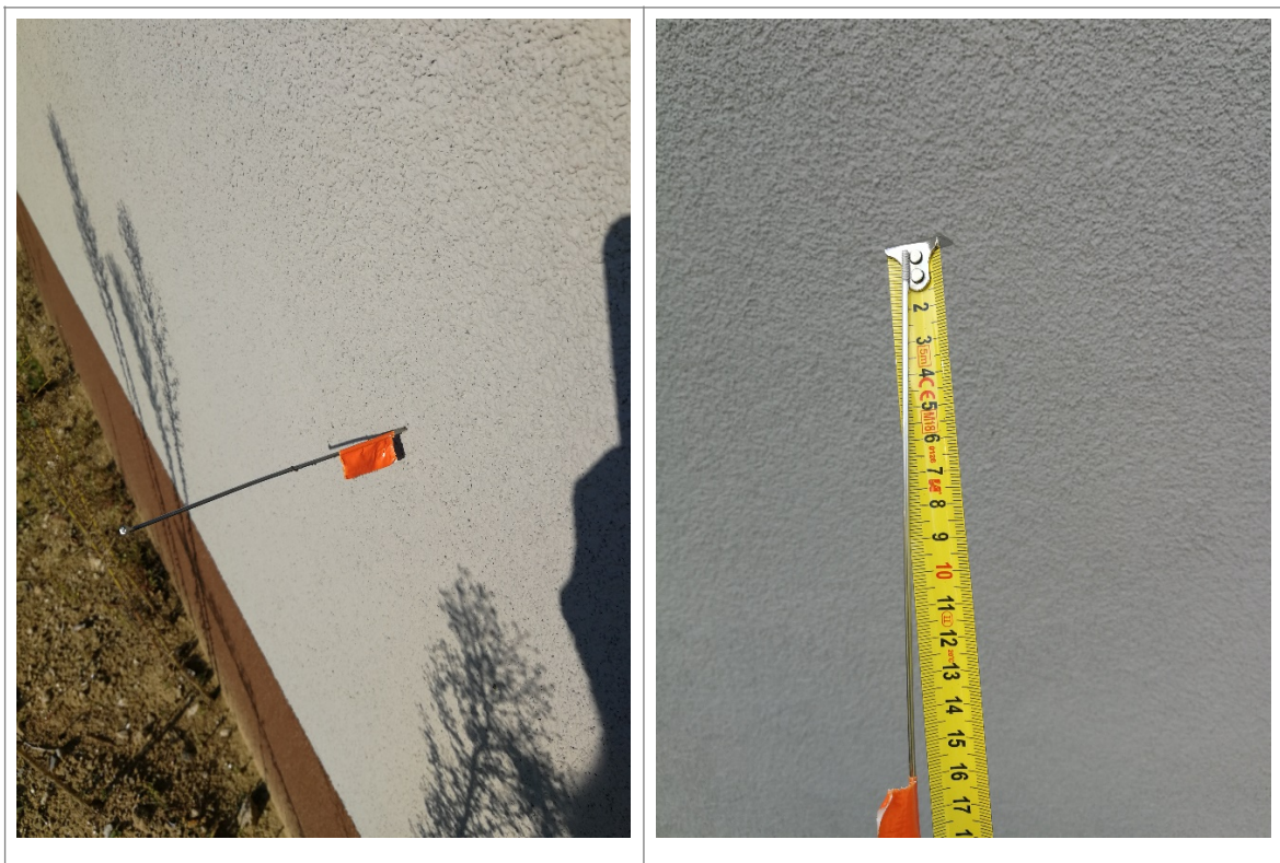
Zdjęcie 6, 7. Grubość termoizolacji ściany.
