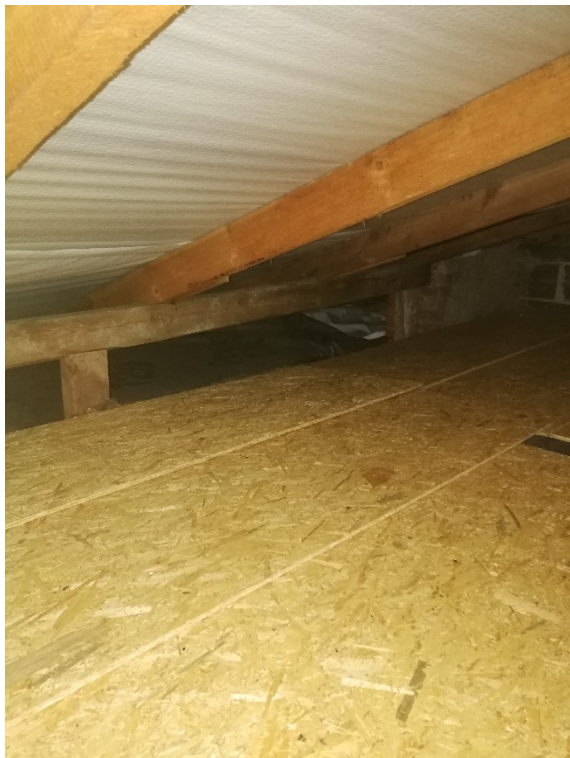
Zdjęcie 10. Płyty OSB na poddaszu.
