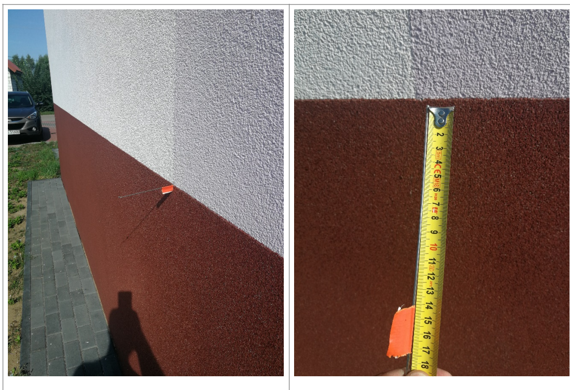
Zdjęcie 4, 5. Grubość termoizolacji ściany.
