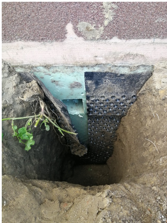
Zdjęcie 4, 5. Płyty XPS na cokole budynku.
