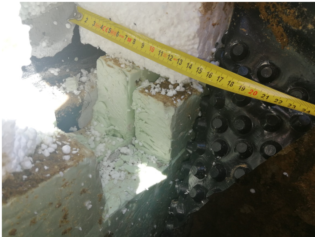
Zdjęcie 4, 5. Grubość termoizolacji ściany.
