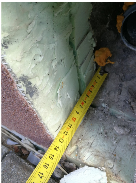
Zdjęcie 4, 5. Płyty XPS na cokole budynku.
