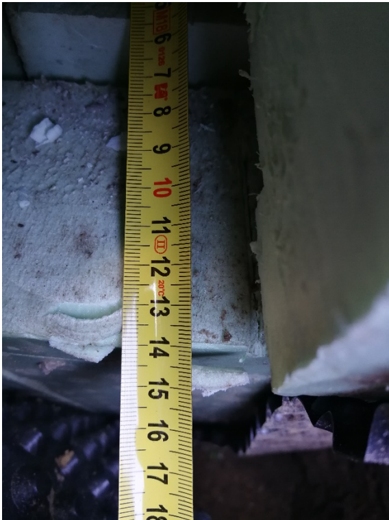
Zdjęcie 2. Grubość płyt styrodur na fundamencie (13 cm).
