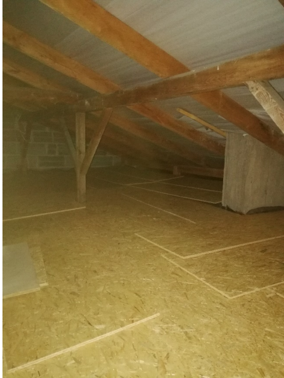
Zdjęcie 10. Płyty OSB na poddaszu.
