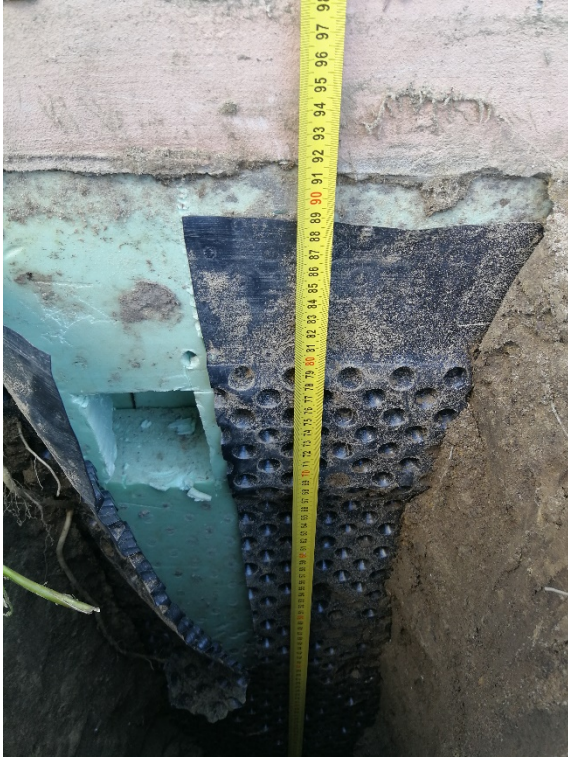
Zdjęcie 2. Grubość płyt styrodur na fundamencie (13 cm).
