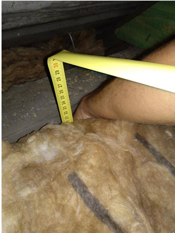
Zdjęcie 6. Grubość wełny na poddaszu 22 cm.
