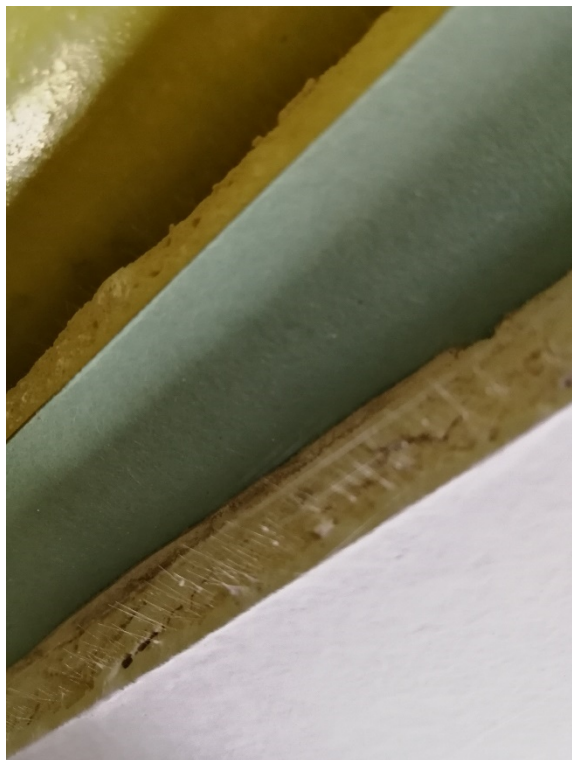
Zdjęcie 9. Podwójna płyta GK widoczna przy ścianie.
