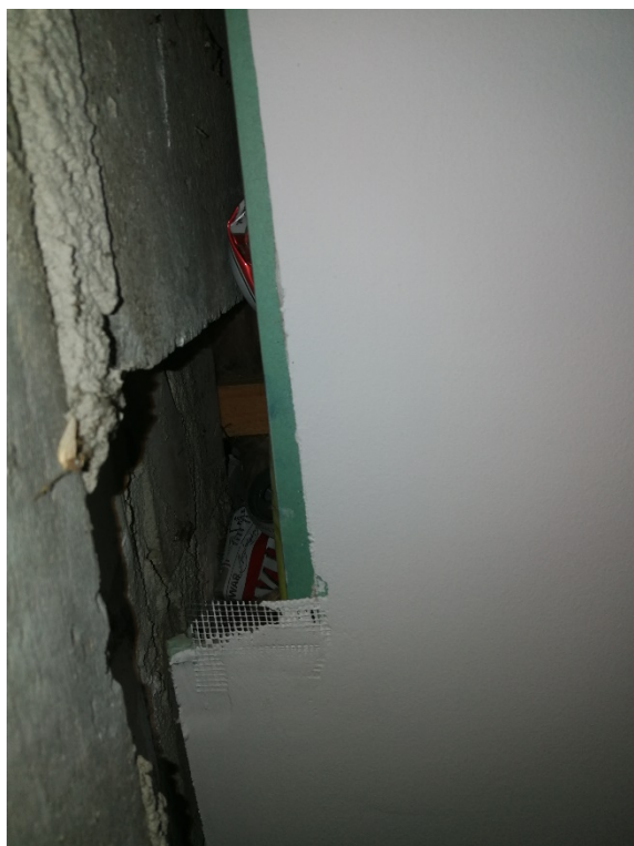
Zdjęcie 2. Podwójna płyta GK widoczna przy ścianie.
