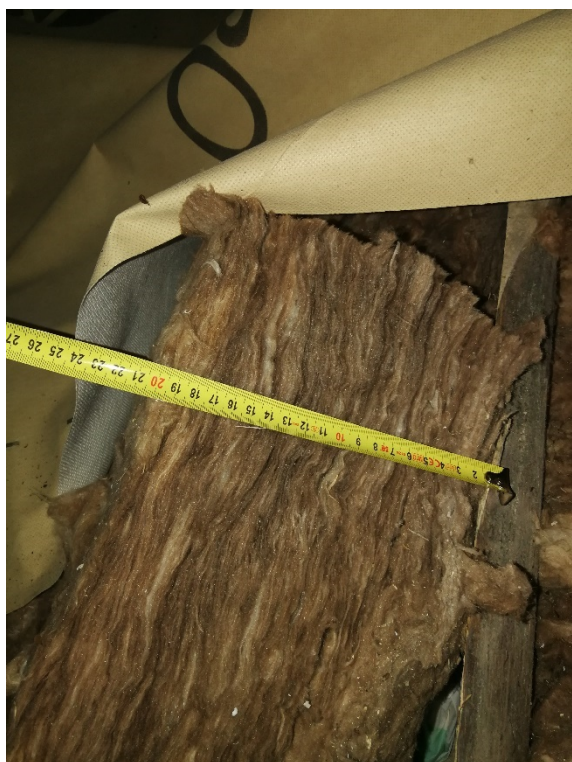
Zdjęcie 8. Wełna mineralna na poddaszu.
